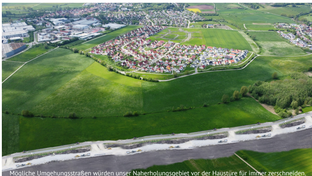
Mögliche Umgehungsstraßen würden unser Naherholungsgebiet vor der Haustüre für immer zerschneiden.
